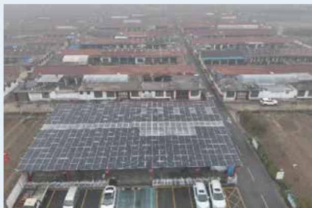
▲ 图 19相当部分屋顶已安装光伏支架
