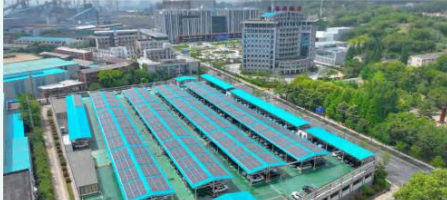
南钢股份在员工停车场安装光伏板
