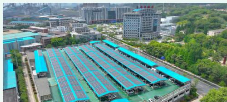
南钢股份在员工停车场安装光伏板
